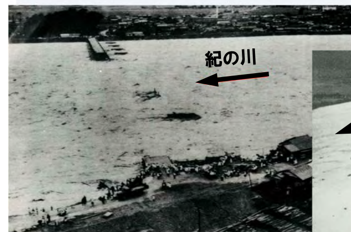
昭和28年7月前線(岩出橋)
