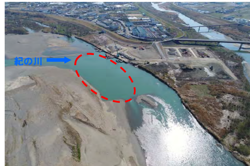
施工後(平成30年3月)
