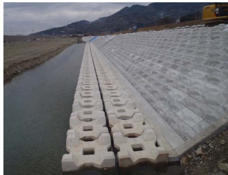
兄井地区施工状況(H27.1月末現在)
