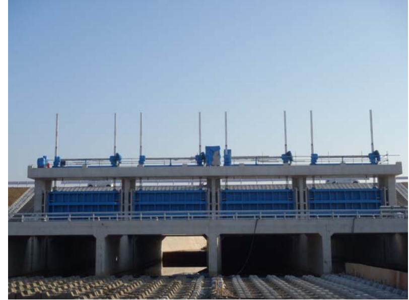
樋門施工状況 (H27.1月末現在)
