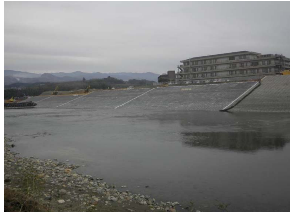
二見地区施工状況（H27.1月末現在）
