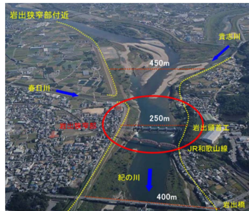
▲ 岩出狭窄部の状況
