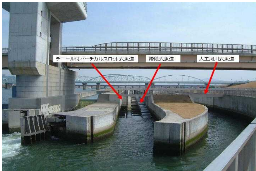
紀の川大堰の3種類の魚道
