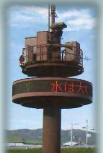
放流警報設備
