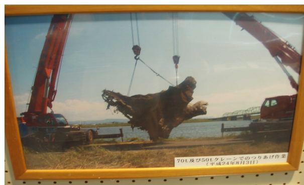
70t及び50tクレーンでのつりあげ作業(平成24年8月3日)
