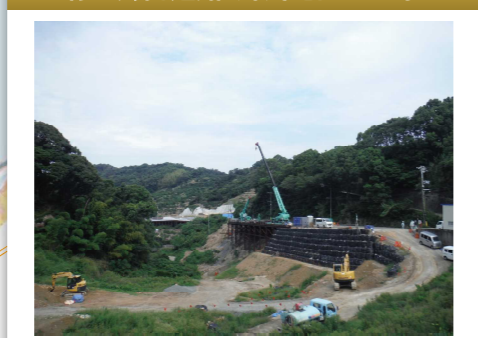
橋梁やトンネル建設に必要な資材等を搬入するために必要な工事用進入路の整備を進めています。
