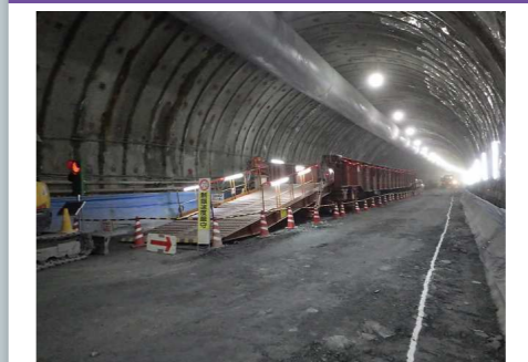
海南市小南地区と冷水地区を結ぶため、有田海南道路で最長となる2,033mの5号トンネル工事を進めています。
