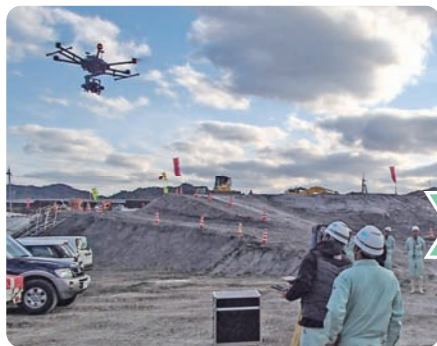
ドローンによる空中写真測量
