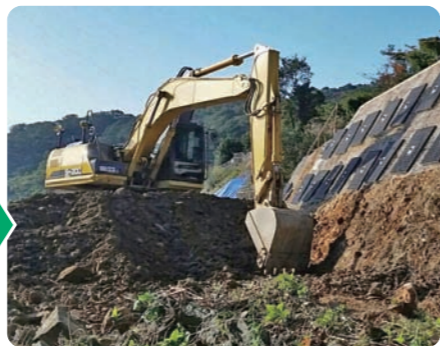
3次元マシンガイダンスによる施工
