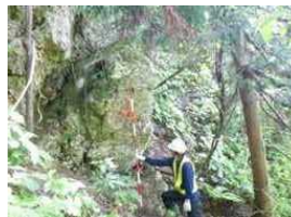
(危険度調査状況)
