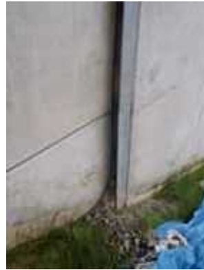
写真 土砂のこぼれ出し例
