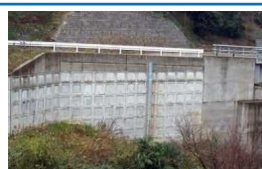
盛土 (補強土壁)
