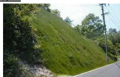
切土 (のり面保護)
