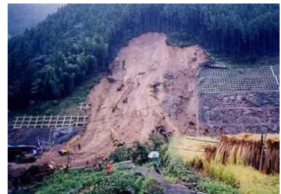
強風化・土砂化斜面での崩壊例
