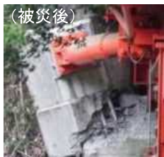
制震ダンパー取付部の損傷
