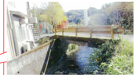
老朽橋の撤去
