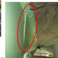
主桁の変形
