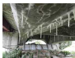
主桁のひびわれ
