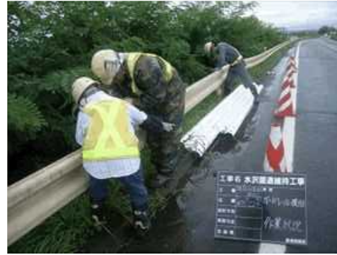
＜防護柵の取替＞
