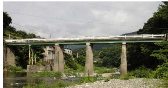
<御鉾橋の状況>
