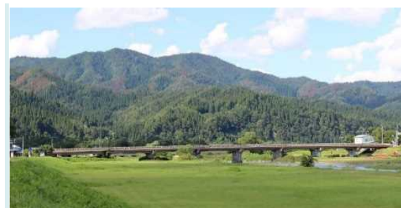
<万石橋の状況>
