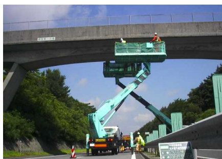
点検実施状況
