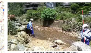
7/30 【道路班】被災状況調査(芦北町)
