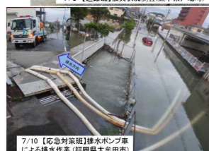
7/10 【応急対策班】排水ポンプ車による排水作業(福岡県大牟田市)
