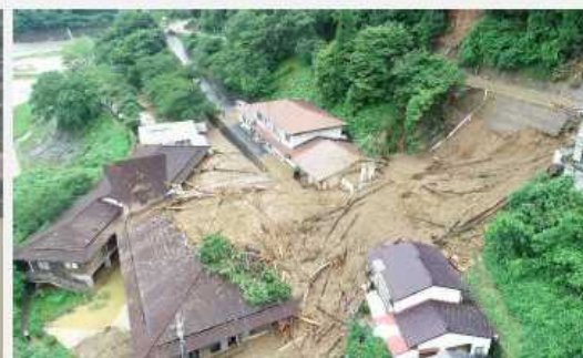
土砂災害の状況 ひた (大分県日田市)
