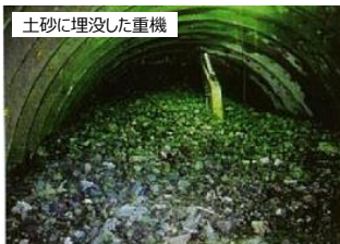
<周辺トンネルでの事故事例(切羽崩壊)> <複数補助工法の組み合わせ事例>
