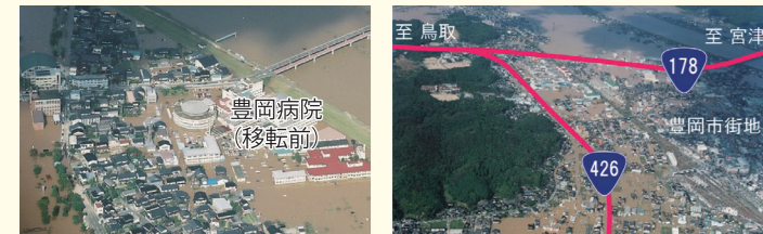
写真① 豊岡病院（移転前）の浸水状況 (H16.10撮影) 写真② 国道178号及び426号の浸水状況 (H16.10撮影)
