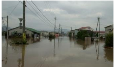
写真①: 水没した国道312号 (豊岡市日高町東芝地内)
