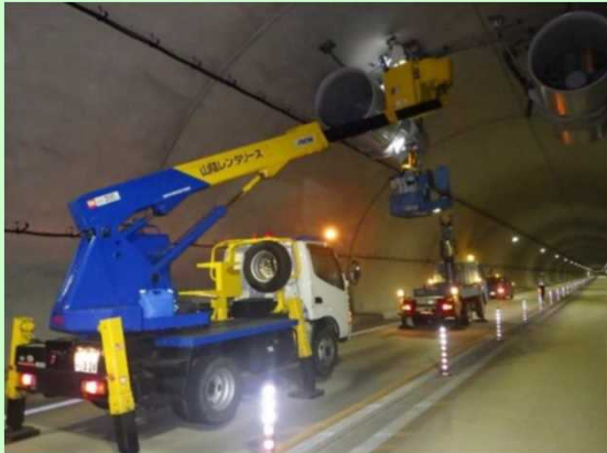
トンネル換気設備点検
