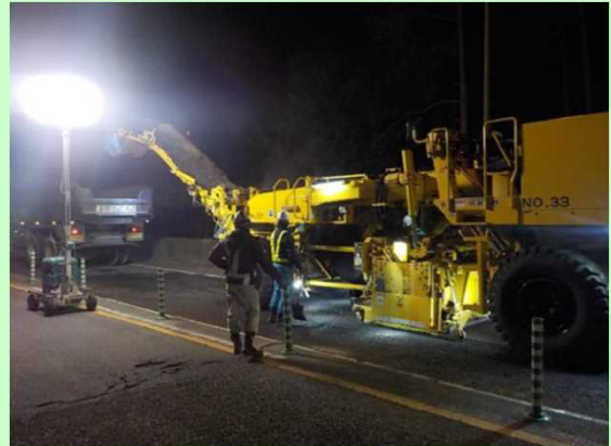
舗装修繕工事
