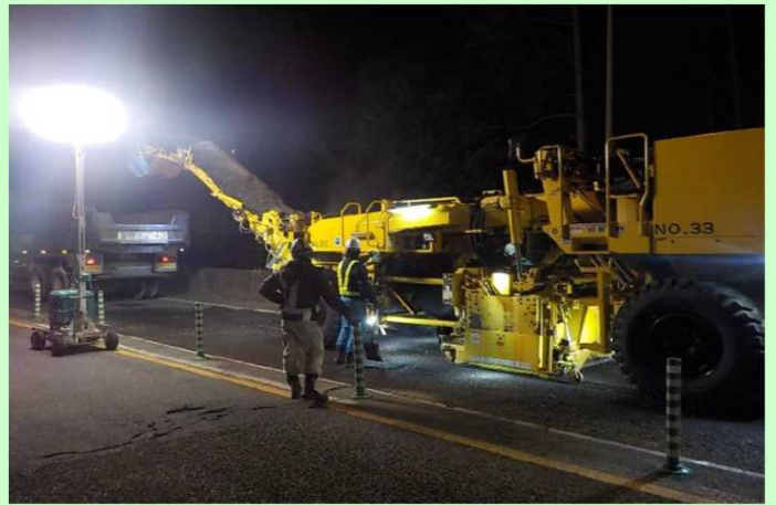
路面補修工事
