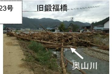
平成16年10月台風23号被災時の流木による影響等、円山川流域は山林からの影響を受けやすい。森林の整備及び保全を推進する中で流出に配慮した間伐を実施し、土砂・流木の流出を抑制する。
