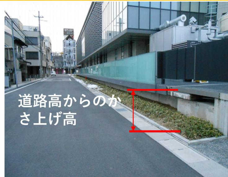
図2 豊岡市役所の耐水化事例<sup>2)</sup>
