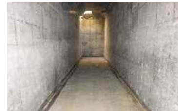
雨水貯留浸透施設のイメージ
