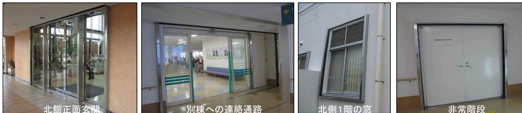
止水板のための角落し設置
