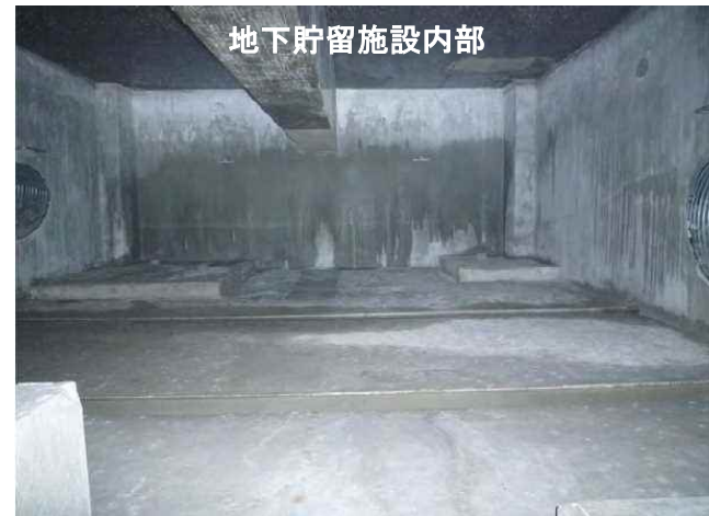
雨水貯留浸透施設の事例【横浜市内】
