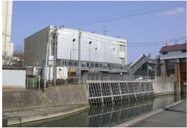
城崎排水機場
