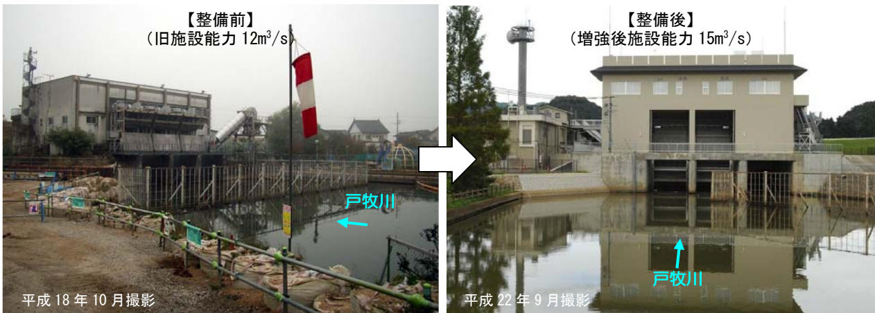
図 1.2.7 豊岡排水機場の整備状況
