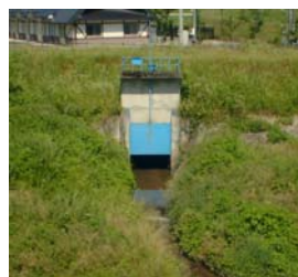
奈佐川第3樋門
