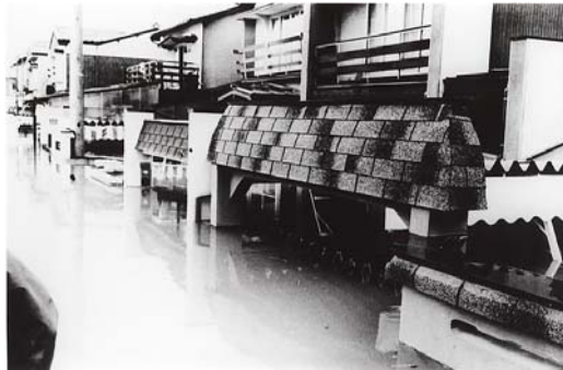
豊岡市内の浸水状況
