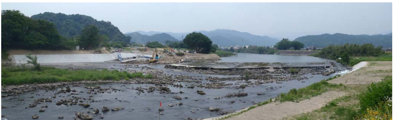
図 1.3.2 蓼川井堰（改築中 平成 24 年 6 月撮影）
