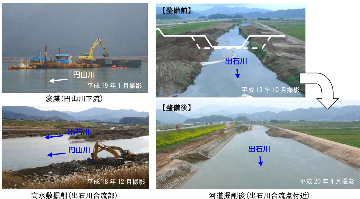
図 1.2.5 河道掘削の状況
