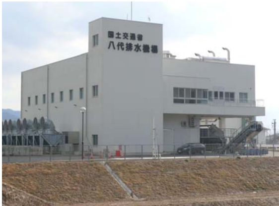
八代排水機場
