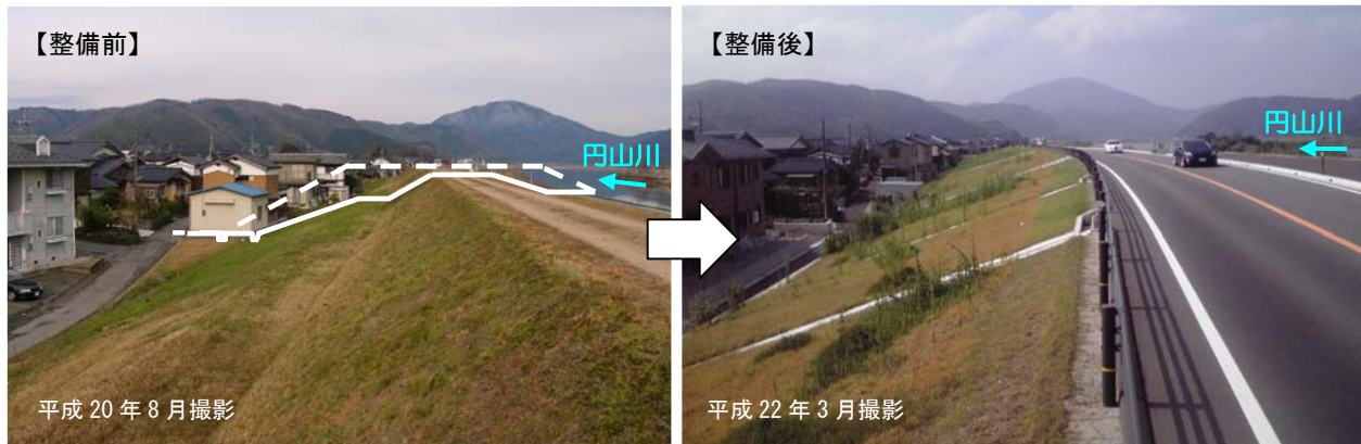
図 1.2.6 円山川堤防の嵩上げ状況 (左図の白の実線から点線の間盛土して強化した)
