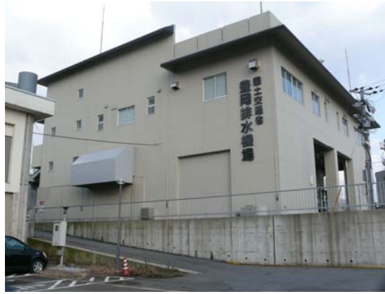
豊岡排水機場
