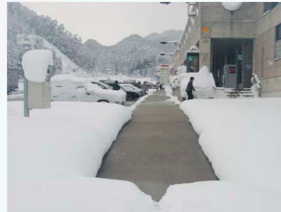
歩道部の融雪状況
