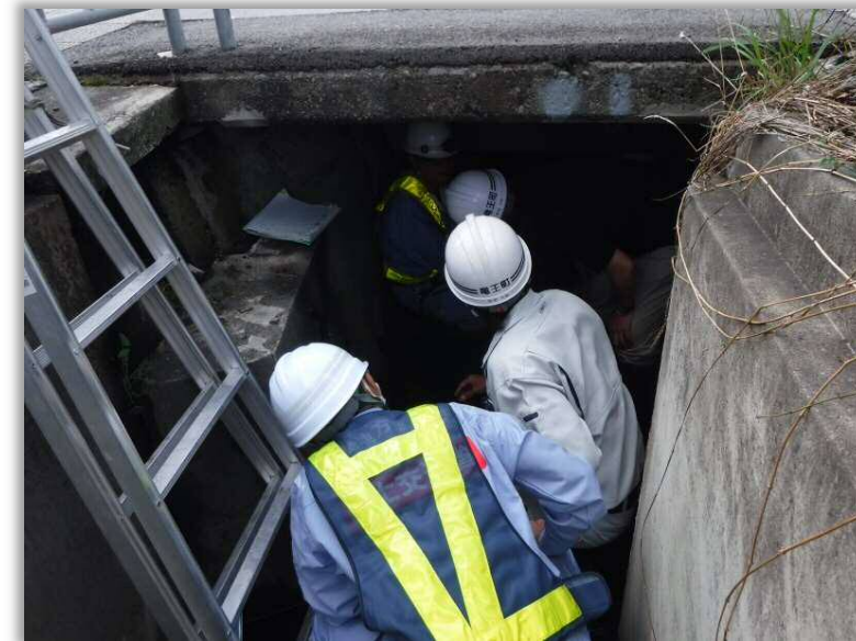
写真：矢倉1号橋側道の点検状況 (平成29年10月3日)
