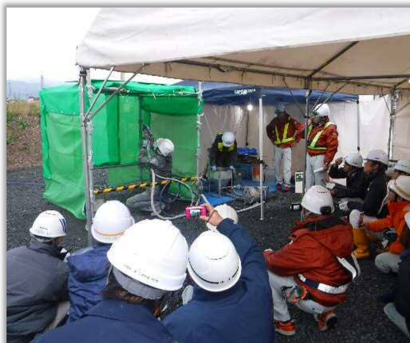
写真：吹付による断面修復の研修（平成29年12月8日）
