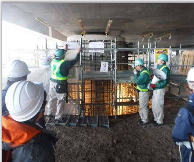
写真：橋脚の耐震補強施工の研修（平成29年11月21日）
