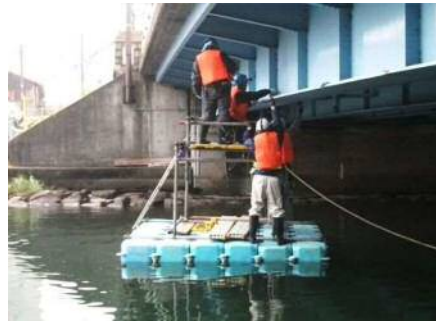
船(フロート)による点検
