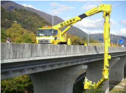
橋梁点検車による点検
