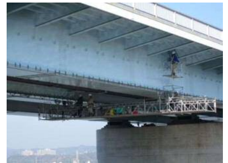
移動式吊足場による点検
