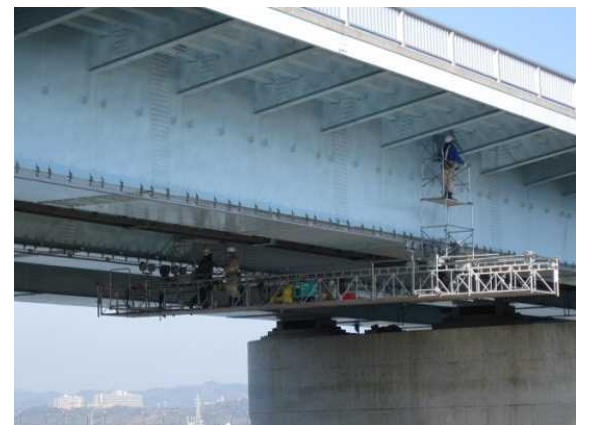
移動式吊足場による点検
