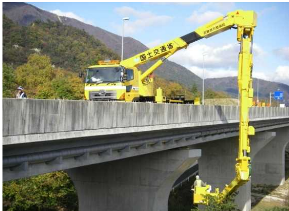
橋梁点検車による点検
