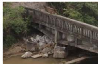
写真-2 平田・小柳線 田中橋
