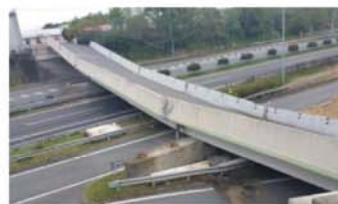
写真-1 県道小川嘉島線 府領第一橋
