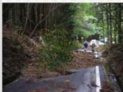
台風による被害状況 国道421号 永源寺町黄和田（平成16年10月）
