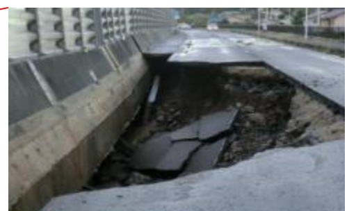
写真④R1.10台風19号による国道42号の陥没(串本町姫) くしもとちょうひめ
