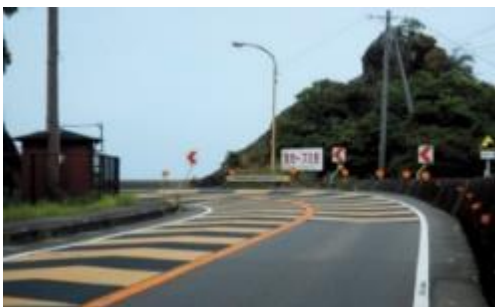
写真①線形の厳しい箇所(那智勝浦町浦神) なちかつうらちょううらがみ
