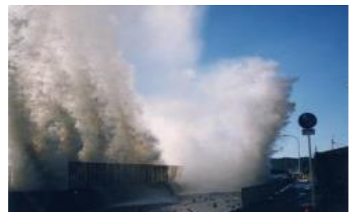
写真②台風時の越波の状況(串本町西向) くしもとちょうにしむかい
