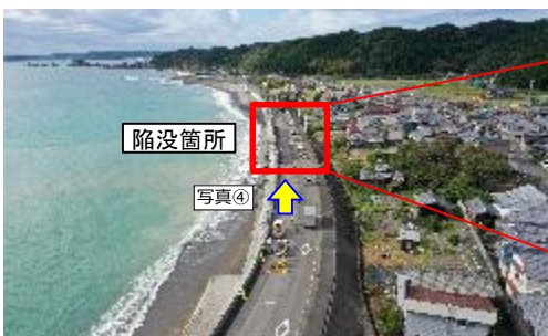
写真③R1.10台風19号による国道42号の陥没(串本町姫) くしもとちょうひめ
