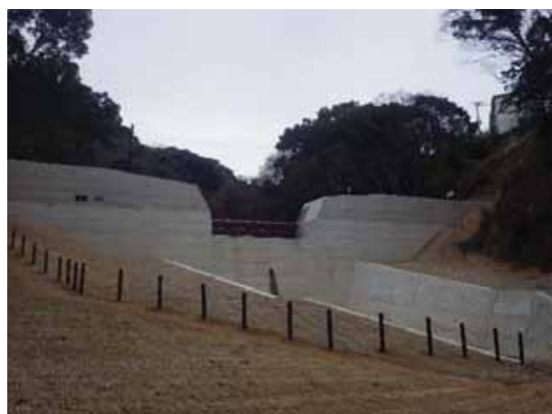
赤旗堰堤補強
