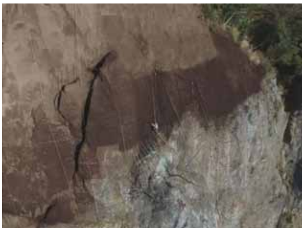
施工状況（遠景）
