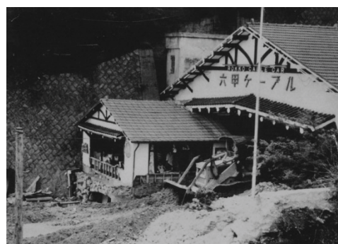
六甲ケーブル下駅から流出した土砂
