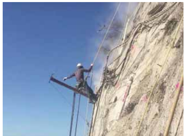
施工状況（近景）
