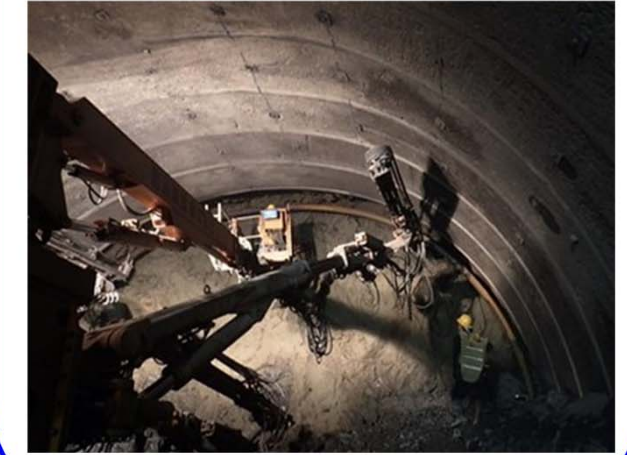
【鋼製アーチ支保工設置状況】
