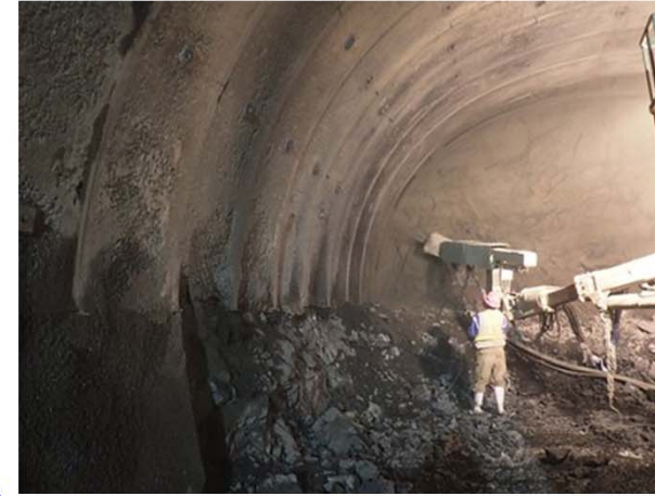
【コンクリート吹付け状況】
