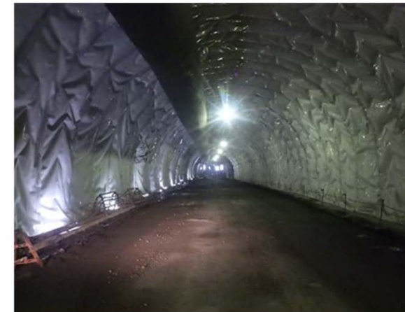
【防水シート設置完了】
