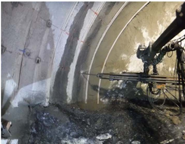
【ロックボルト施工状況】
