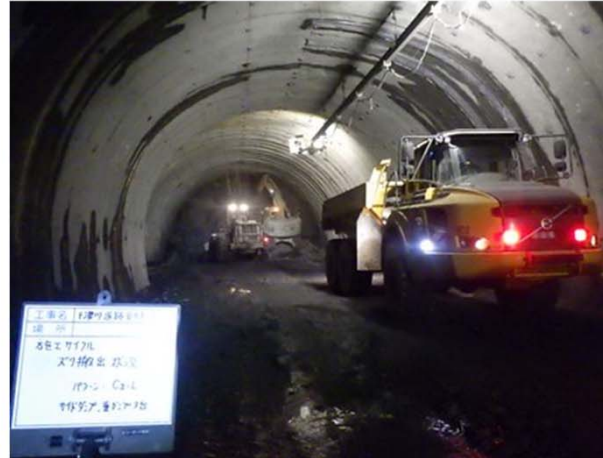
【重機を使用したズリ搬出状況】
