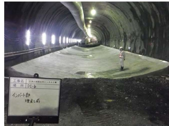
【インバート施工完了】
