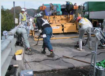
(床版増厚状況)
