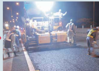
(舗装復旧状況)
