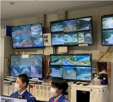
▲ モニターの分割画面で管内の砂防施設を監視
