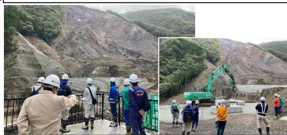
赤谷地区では無人化施工による土砂の敷き均しの実演、自動化施工によるブロック据え付け技術の解説をしました。
