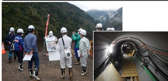
長殿地区では残存する湛水池の解消を目的とした排水トンネル整備について、施工中のトンネル内を案内しました。
