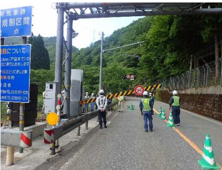
▲訓練中の規制状況
