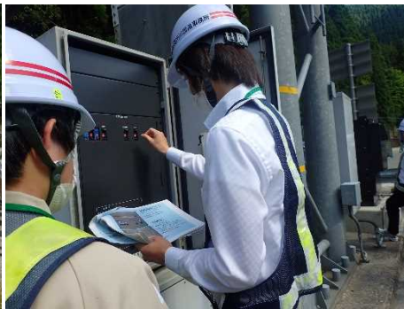
▲遮断機の操作説明の様子（電動操作）
