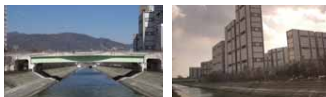
宮川大橋 芦屋浜シーサイドタウン
