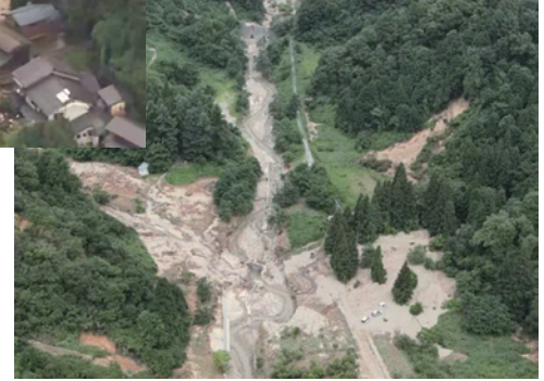
令和4年8月の大雨に伴い発生した土砂災害(山形県飯豊町)
