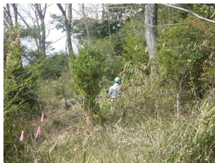
南側斜面整備①
