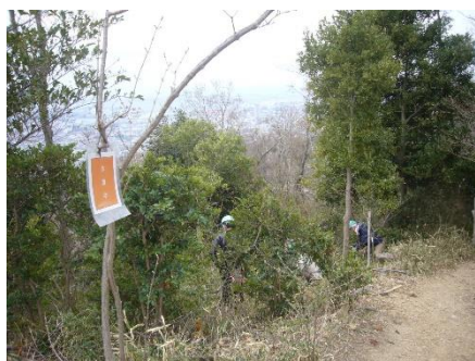
西側斜面整備作業
