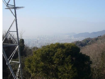
鉄塔工事後の眺望
