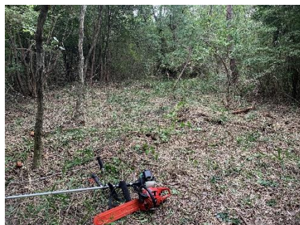
鹿松側三叉路作業後
