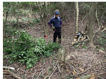
谷筋伐採作業後
