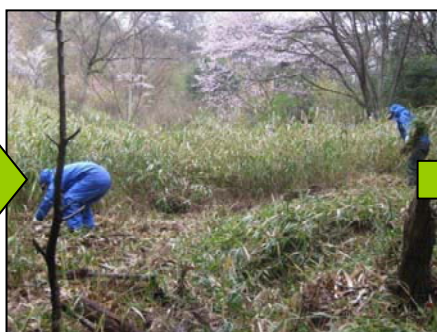
入口周辺（作業中）
