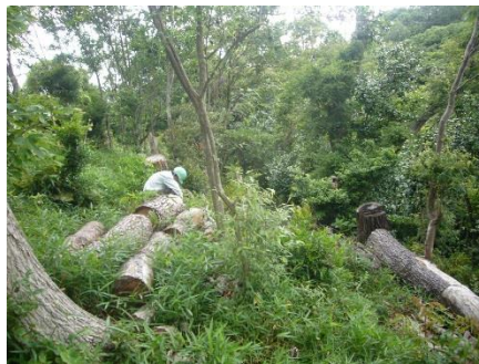
地道な抜根作業
