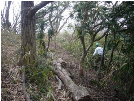
西側斜面 整備
