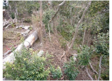
東側斜面 整備後
