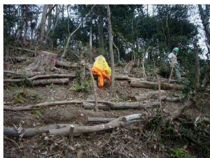
土留めの設置
