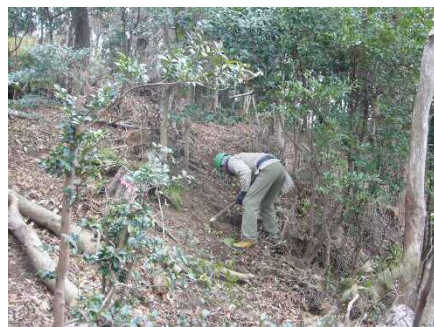
通路整備作業開始
