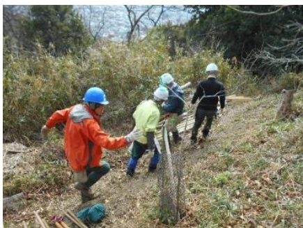
作業道の整備作業
