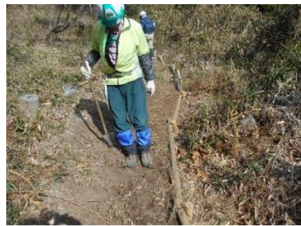
整備された作業道
