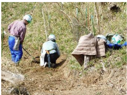
作業道の整備作業
