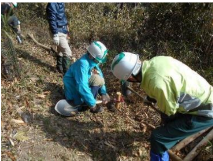
作業道の整備作業
