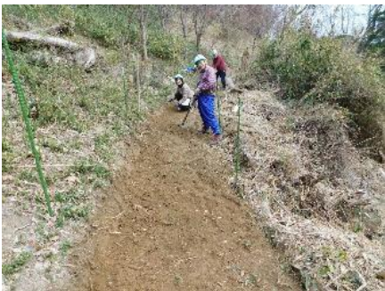
整備された作業道
