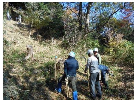
作業道整備作業
