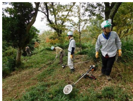
作業道の整備作業
