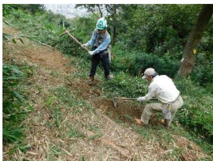
作業道の整備作業
