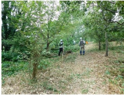
整備作業完了（最上部）
