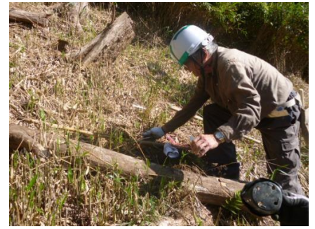
植樹の穴掘り
