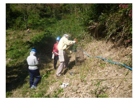
ウッドガードの取り付け
